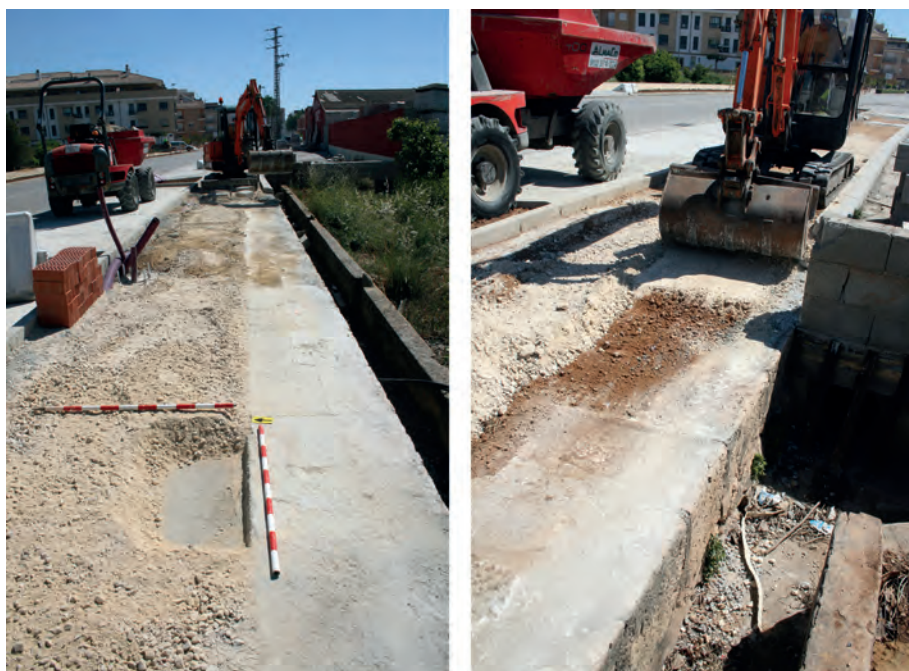
Fig. 5. Els carreus conformaven una vorera d'entre 76 i 80 cm d'ample i a la vegada feien de paret d'una séquia
