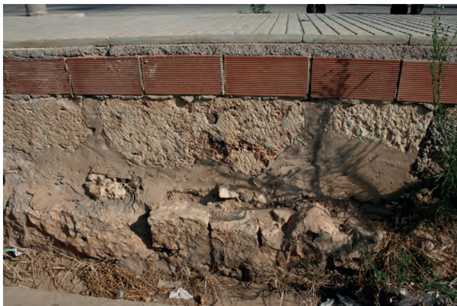
Fig. 16. Carreus assentats sobre altres fragmentats a la parcel·la núm. 7 del camí del Cementeri
