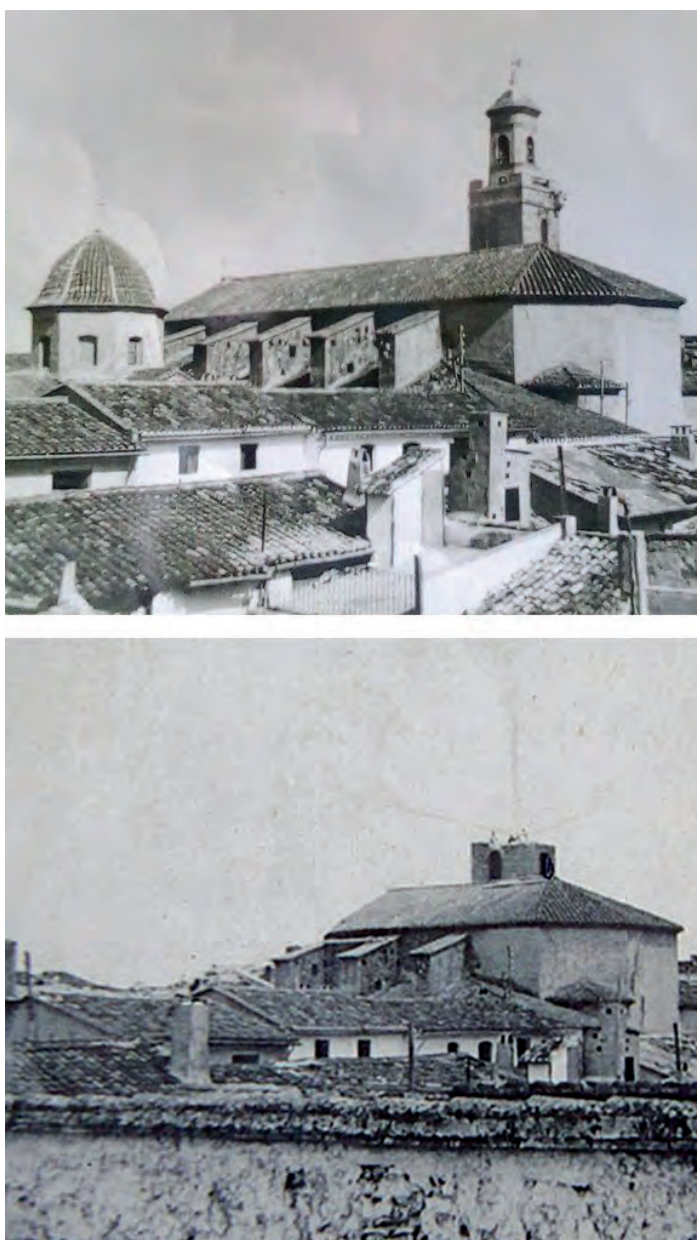
Fig. 21. Comparativa, des d'una mateixa perspectiva, de l'església abans de l'enderroc i mentre aquest es duia a terme. En la imatge inferior es pot apreciar com ja ha desaparegut la meitat de l'edifici començant des de la porta d'entrada, així com la capella de la Comunió, i com s'està executant la demolició del campanar (fotografies de Ramón Trullenque Esteve realitzades des de la fàbrica de licors Jaramostel)
